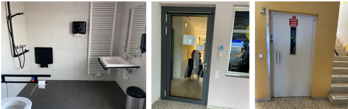
Barrierefreies Bad, barrierefreie Tür im Treppenhaus, Aufzug im Bestand (vor dem Umbau). Quelle: IfS
